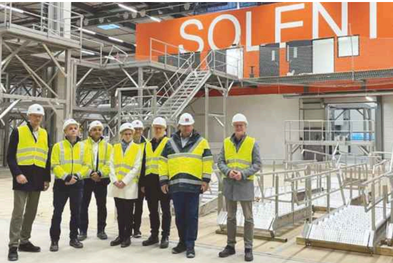
Stadt und EWG besuchten die Baustelle „Solent Rheine“ (v.l.): Ingo Niehaus, Martin Flatau, Boris Lubitowski, Milena Schauer, Thomas Konrad, Mathias Krümpel, Michael Molsberger und Dr. Peter Lüttmann.
